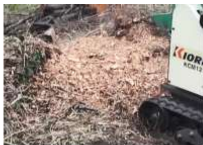
・伐採木の破砕 伐採木をチップパーなどを用いて、厚さ10mm以下を目安としてチップ化する。
